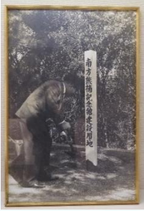
南方熊楠記念館 建設用地地鎮祭(1963年)
